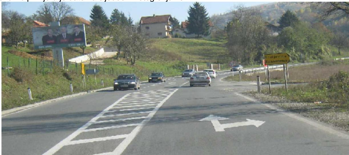
Fotografija 1. Tipično projektiranje T-raskrsnice s trakom za skretanje lijevo
